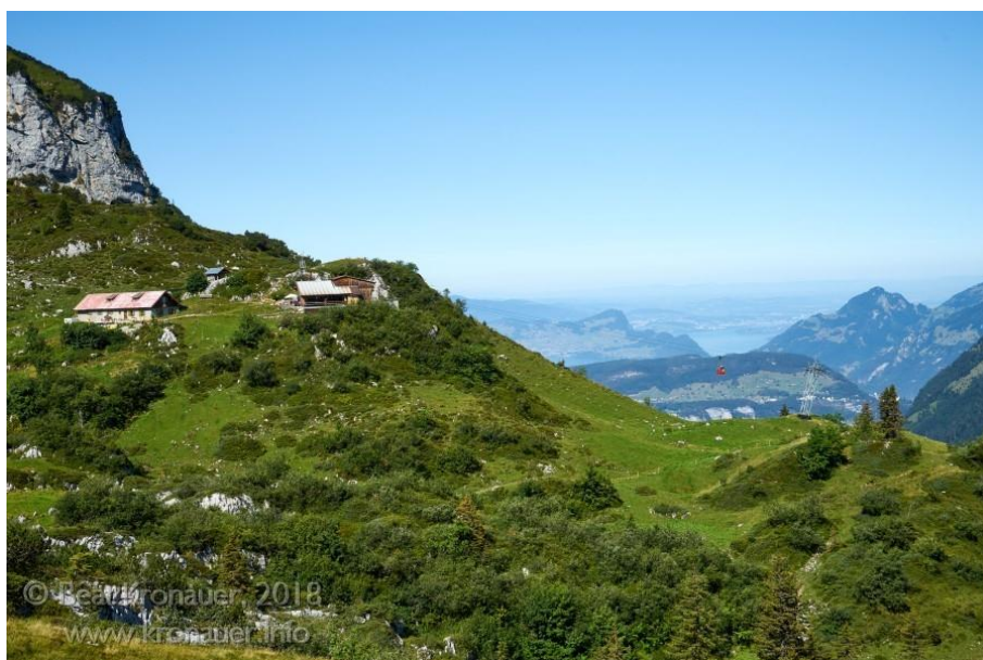
Luftseilbahn Chäppelibergr-Spilau: Bergstation Gitschen (1716 m)
